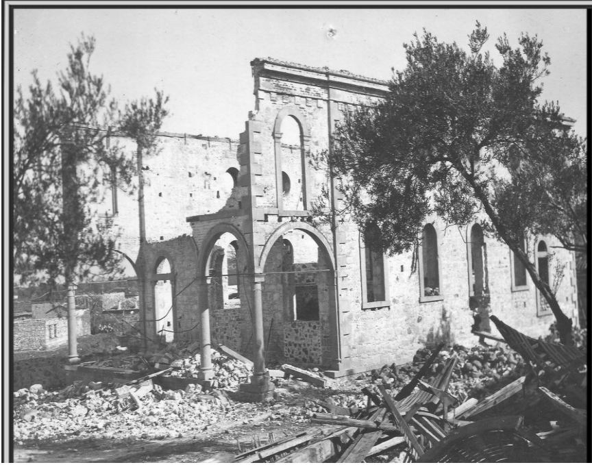
Görsel 6 - 1939 Dikili Depremi'nde Yıkılan Bir Bina 108
