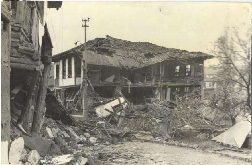
Resim-6 - Deprem bölgesinde yıkılan binalar
