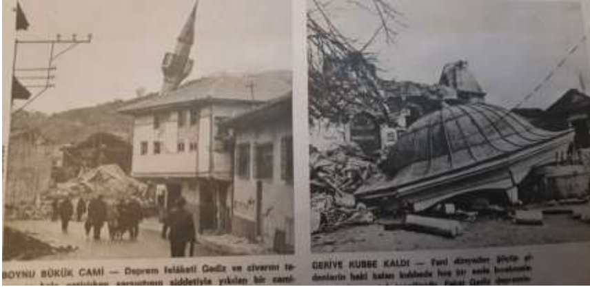
Resim-5- Deprem bölgesinde yıkılan camiler
